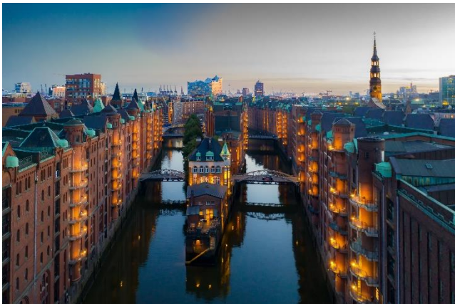
Die Hamburger Speicherstadt – der weltweit größte historische Lagerhauskomplex. ©tripz.de
